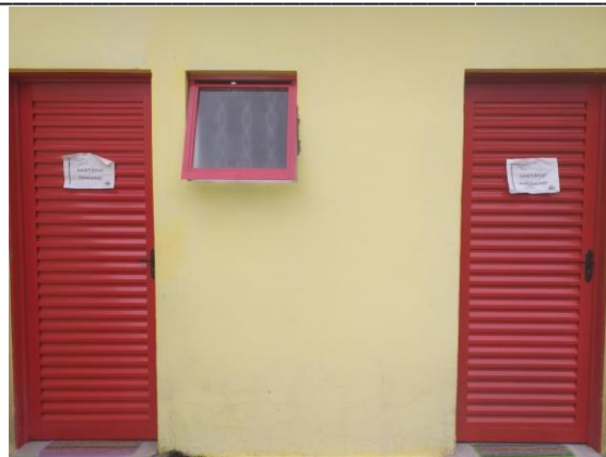
Portas dos Sanitários Masculino e Feminino
